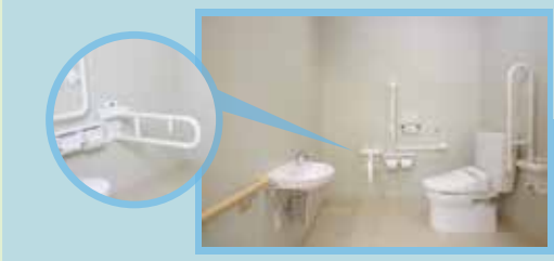
便器の前方にも介助バー を設置し、より「座りやすさ」「立ちやすさ」を考えた作りとなっています。
